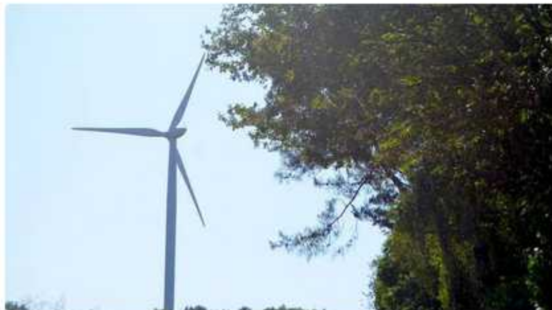
Eolienne Berthe à Sévérac - (PHOTO PRESSE OCEAN)
